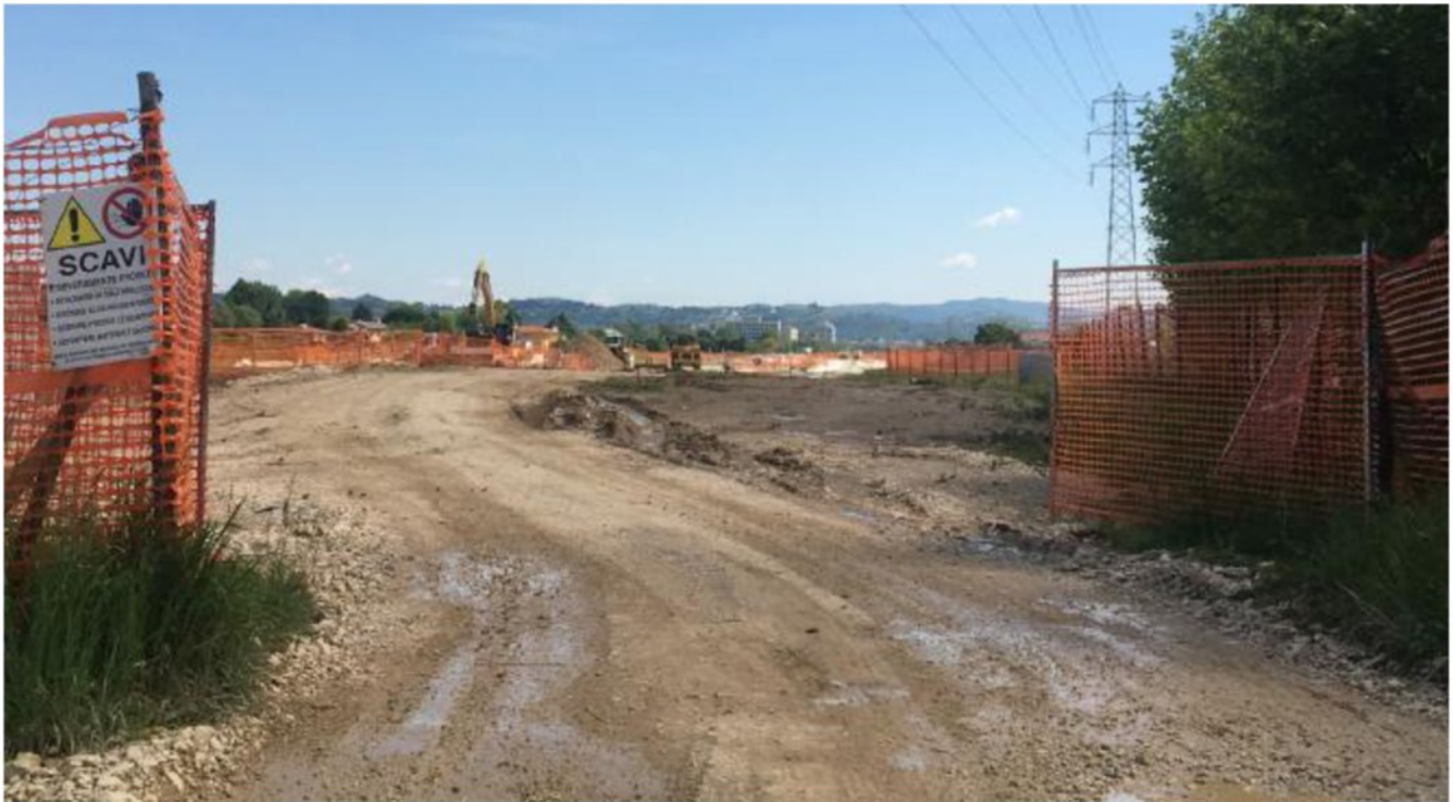
Il cantiere della bretella dell'Albera all'intersezione con strada Ambrosini: i lavori per il sottopasso sono distanti
