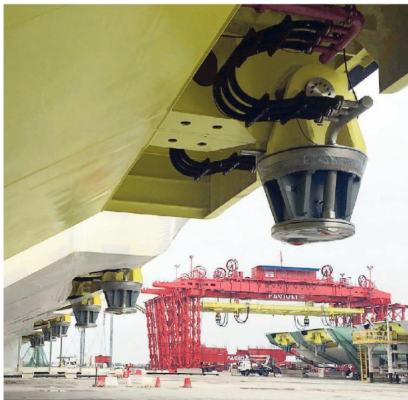
Lavori alle paratoie del Mose: la manutenzione costerà 100 milioni all'anno
