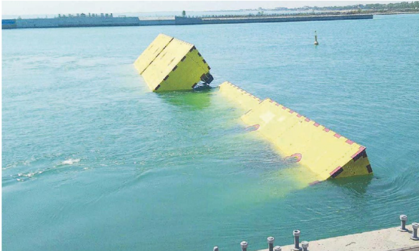
Prove di sollevamento delle paratoie alla bocca di porto di Lido
