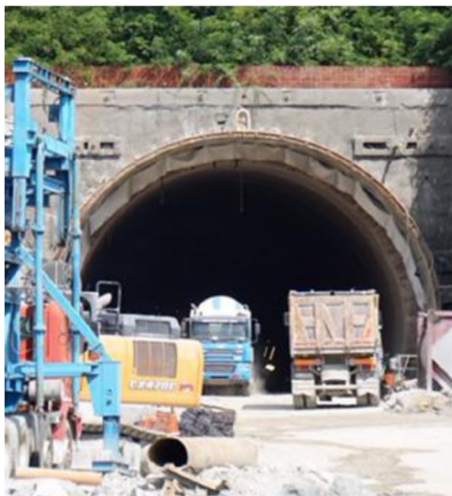
Il cantiere in località Covolo a Malo: alta tensione con i residenti
