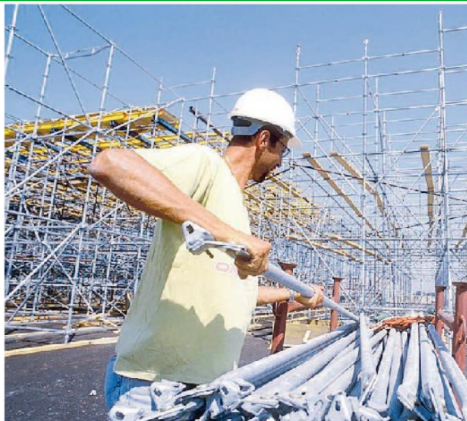
Decreto sblocca-cantieri nel mirino dell'Ance Fvg.
