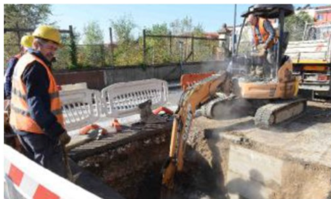
Operai e macchinari al lavoro in un cantiere stradale. ARCHIVIO
