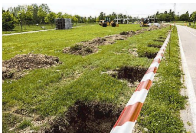
Il cantiere a San Giuliano
