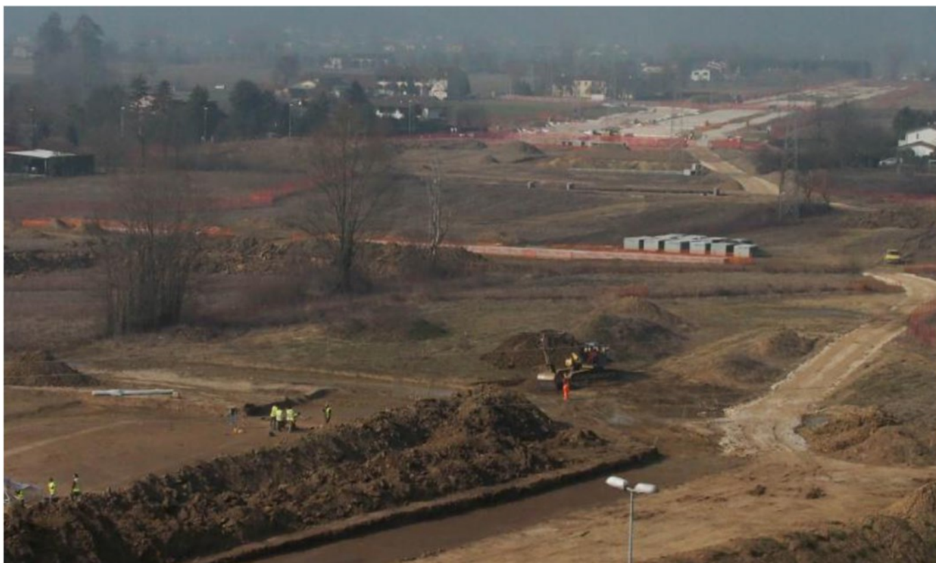
Un'immagine dall'alto dell'area dei lavori della futura bretella dell'Albera
