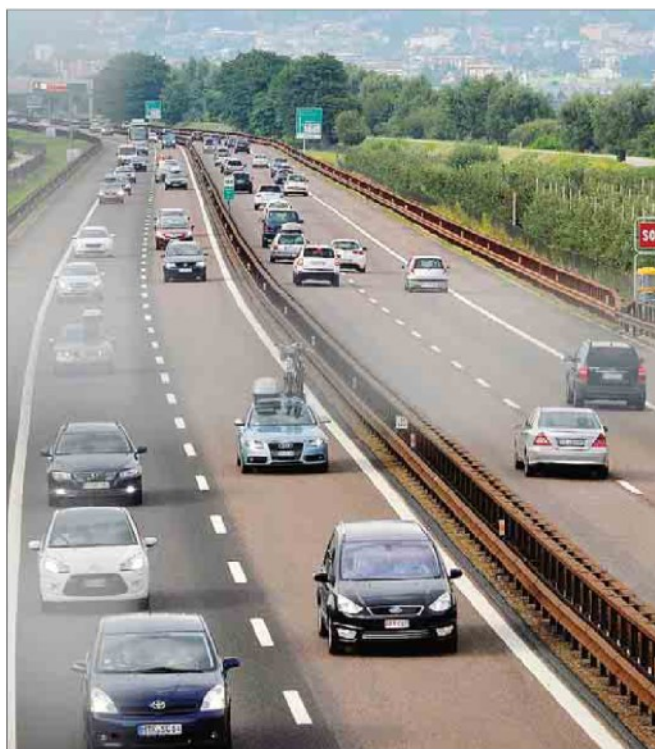
Traffico estivo sull'autostrada A22
