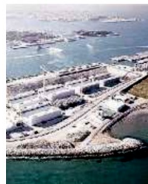
CANTIERI I lavori del Mose
