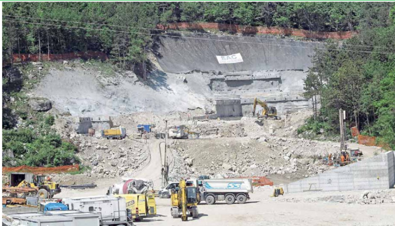
• Il cantiere della galleria Loppio-Busa a passo San Giovanni: l'impresa sta cercando altri 87 lavoratori FOTO GALAS
