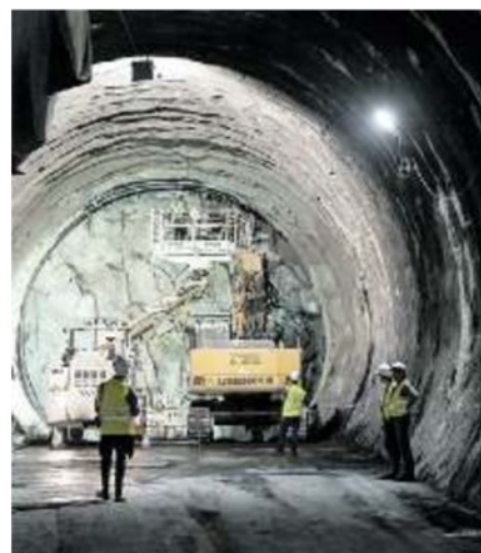
Un cantiere della Tav nella parte francese dei lavori dall'Alta velocità
