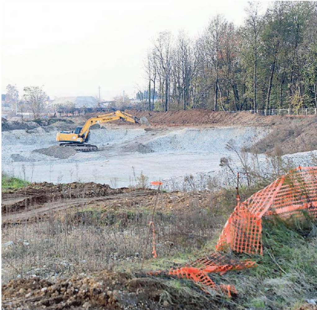
Il cantiere della Pedemontana nel Bosco della Speranza a San Vito di Altivole
