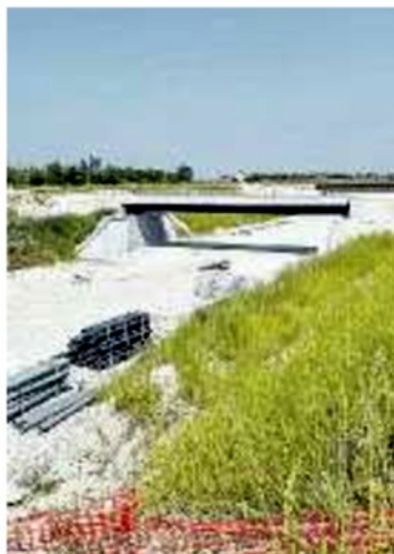
IN PROVINCIA la Superstrada è stata completata al 45%
