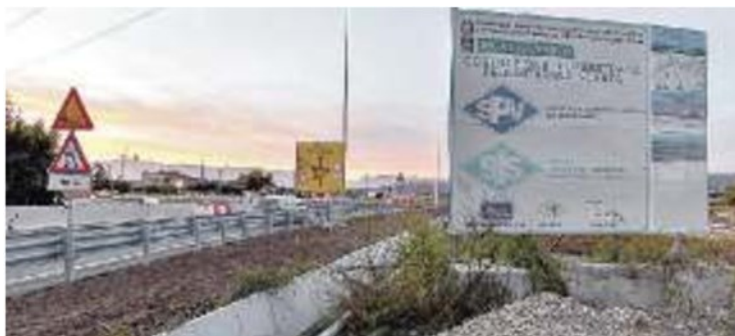
CANTIERE Uno dei tratti della Pedemontana ancora in costruzione
