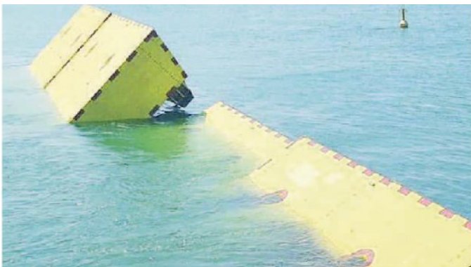
I cassoni del Mose: i lavori dovrebbero concludersi entro il 2021
