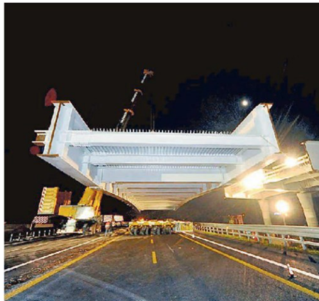
Inaugurazione notturna per il ponte sulla A4 tra Castello e Porpetto
