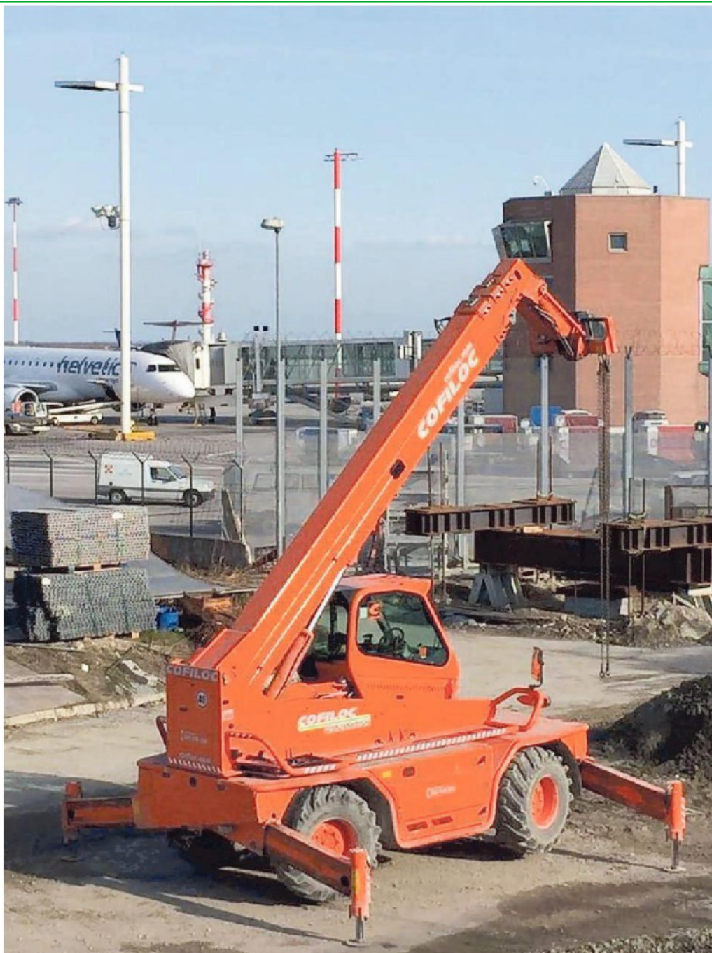
Un cantiere di lavoro all'aeroporto Marco Polo di Tesserà
