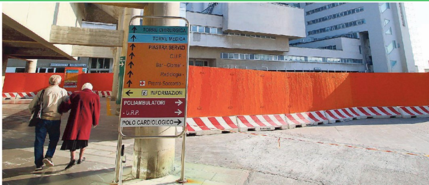
Un'immagine della situazione di stallo del cantiere nel piazzale interno dell'ospedale di Cattinara. La maxi riqualificazione è ferma fino a data da destinarsi
