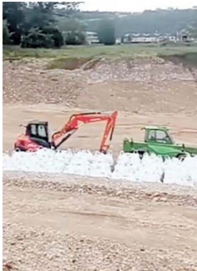
LAVORI Uno dei cantieri della Pedemontana, la superstrada a pagamento che collegherà Montecchio Maggiore a Spresiano. Sarà lunga quasi 95 chilometri. La previsione è di aprirla alla fine del 2020. A lato il ministro dell'Ambiente Sergio Costa
