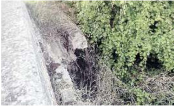
ADRIA Il pessimo stato del ponte sullo scolo Bresega
