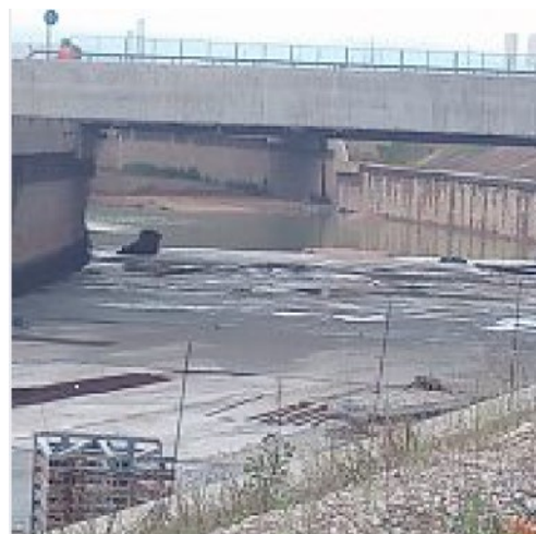
Allagamenti Acqua piovana nelle trincee della Pedemontana
