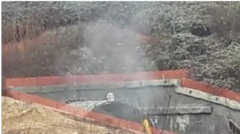
Il fumo che esce dopo un'esplosione nella galleria di Vallugana.K.Z.
