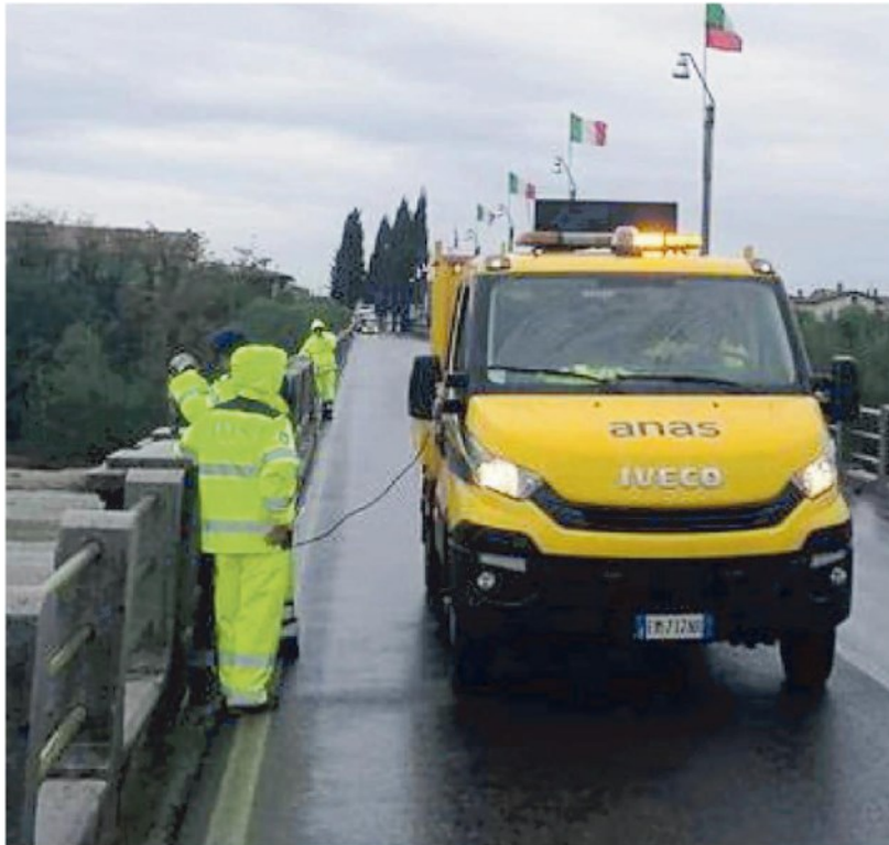
I tecnici dell'Anas lunedì al lavoro sullo storico viadotto. Quaranta borchie metalliche rileveranno le irregolarità strutturali del ponte sul Piave
