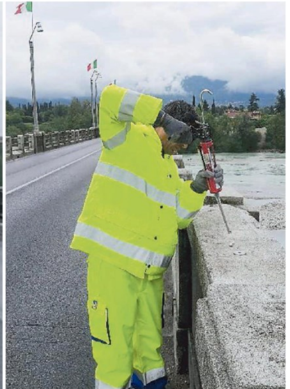
I tecnici dell'Anas lunedì al lavoro sullo storico viadotto. Quaranta borchie metalliche rileveranno le irregolarità strutturali del ponte sul Piave
