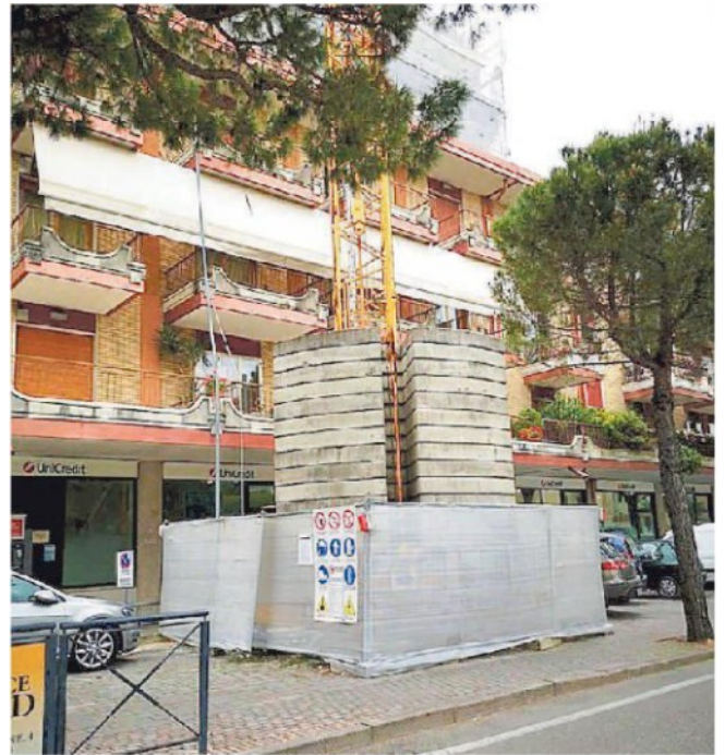
Il cantiere sequestrato dalla polizia locale a Jesolo FOTO TOMMASELLA
