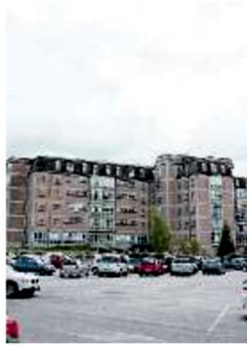
LAVORI ANTISISMICI Il San Martino verrà letteralmente ingabbiato
