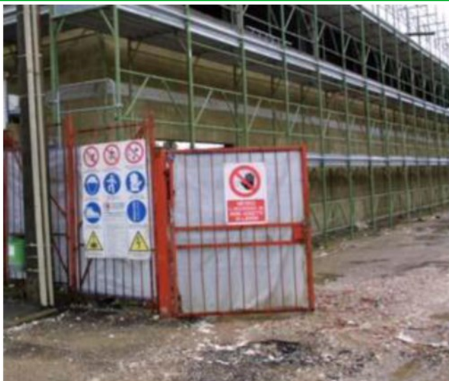
Sono stati molti i cantieri attivati grazie ai fondi statali. ARCHIVIO
