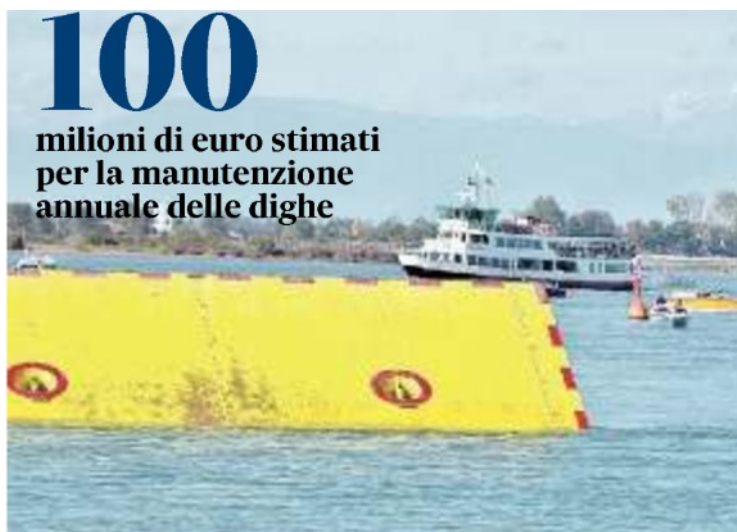
ACQUA ALTA Una prova delle paratoie mobili alle bocche di porto
